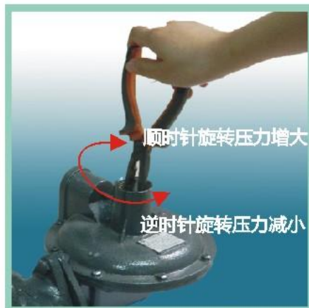
出口压力设定示意图(图3)
